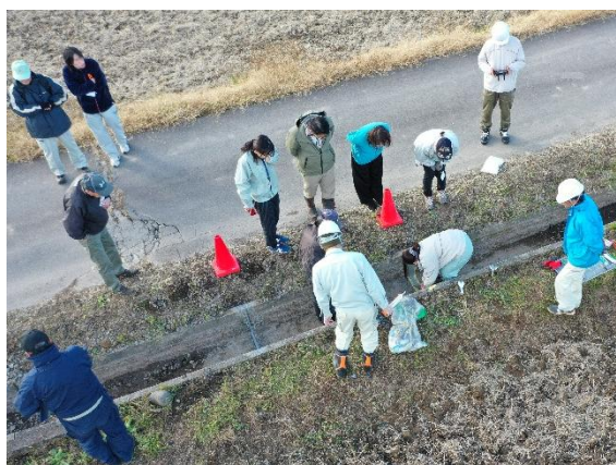
技術研修会（試験施工）：佐久市
