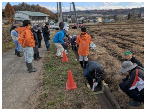
技術研修会（試験施工）：飯綱町
