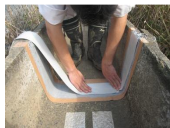
接着型テープによる目地補修
