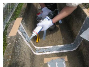
シーリング材による目地補修
