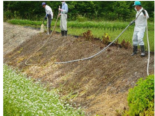
芝の吹き付け作業
