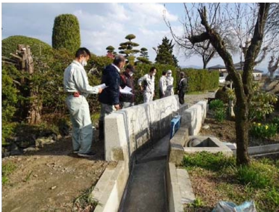
補修した水路
