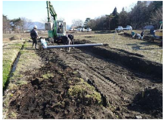
建設中のホタル水路
