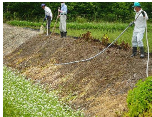
芝の吹き付け作業
