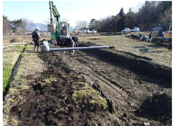
建設中のホタル水路
