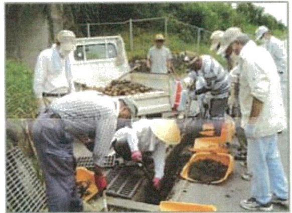
水路の泥上げ作業
