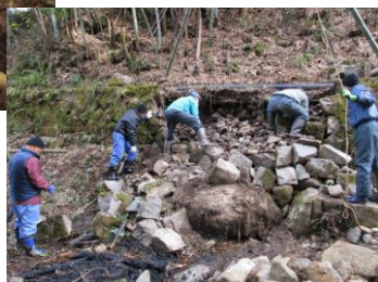
石積水路の補修
