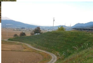
設置された小段
