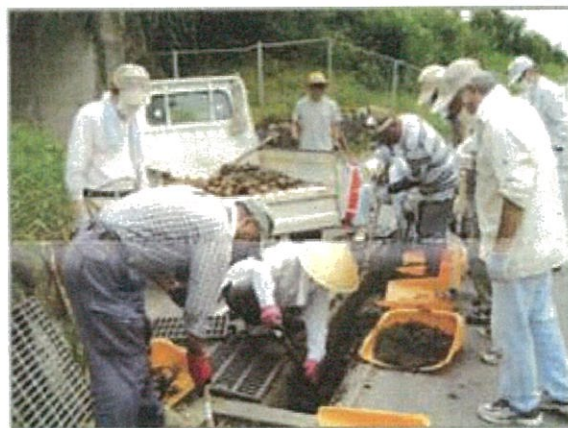
水路の泥上げ作業
