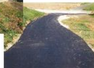
補修後の農道
