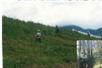
ため池堤体の草刈り
