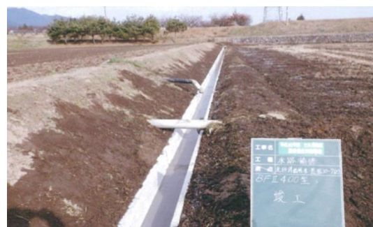
【土水路からコンクリート水路に改修】
