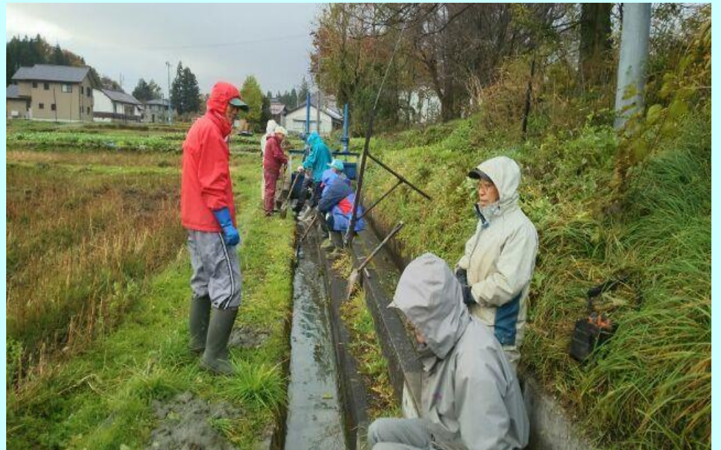
水路清掃作業
