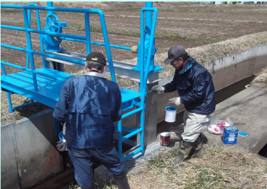
水路の整備(水門ゲートの塗装作業)
