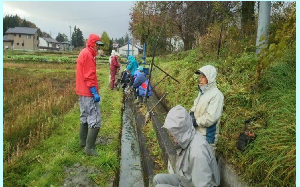
水路清掃作業
