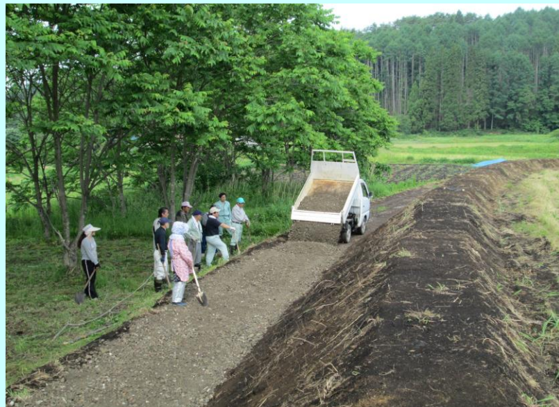
農道整備(構成員による工事)
