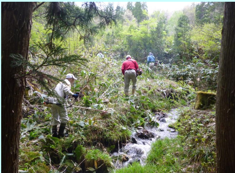
水路の草刈り(上流)
