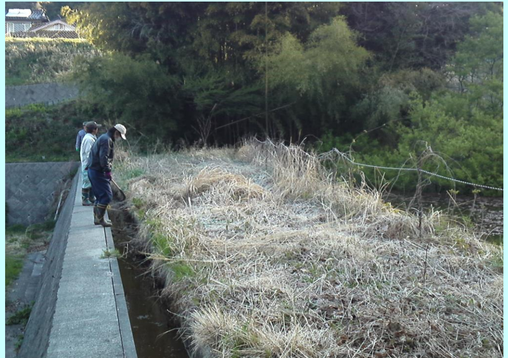
ため池・水路の点検
