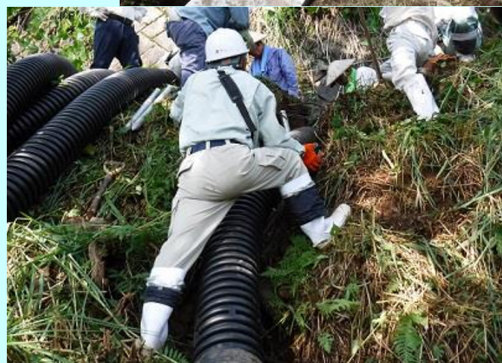
水路蓋掛け パイプ布設 作業
