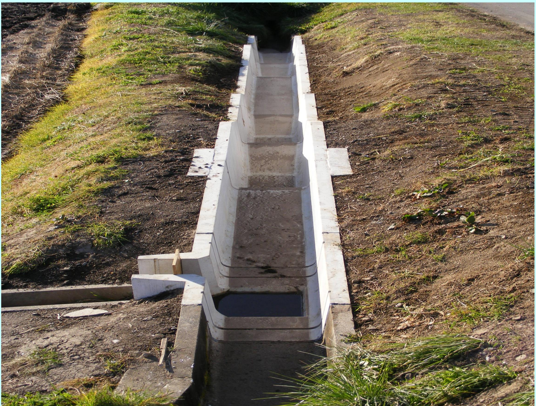
— 工事が完成し新しくなった水路 —
