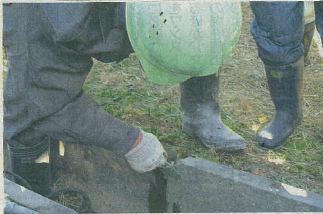
⑤水路の目地に補修材料を注入(充填工法)
