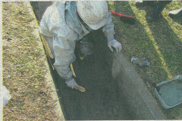
⑥下地を塗った後、補修材料を刷毛で塗る(被覆工法)
