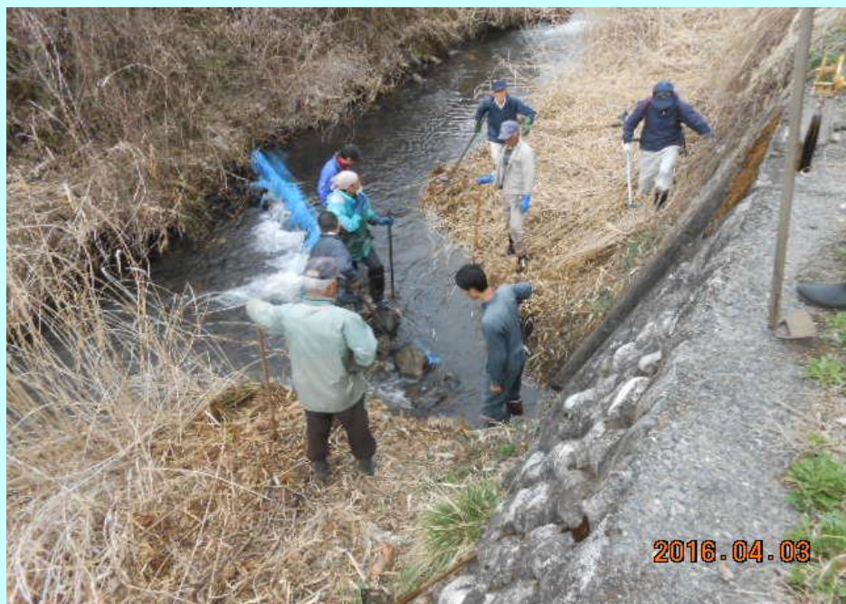
水路の泥上げ
