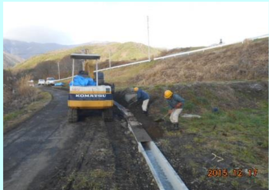
長寿命化(U字溝の更新)
