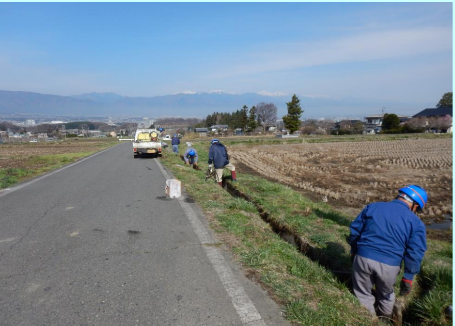
水路の目地補修作業
