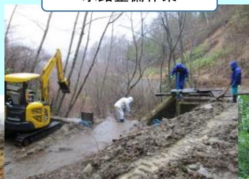
水路整備作業
