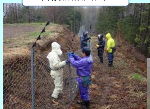
防護柵補修作業
