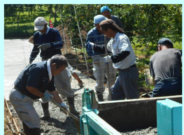
【 農道舗装作業の実施 】 未舗装農道をコンクリート舗装に整備し、果樹等の荷傷み防止や、安心して農耕車両を運転できるようになりました。
