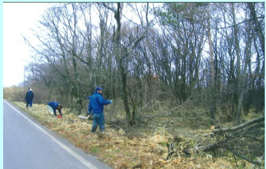
倒木等の危険個所の支障木の伐採を行います。
