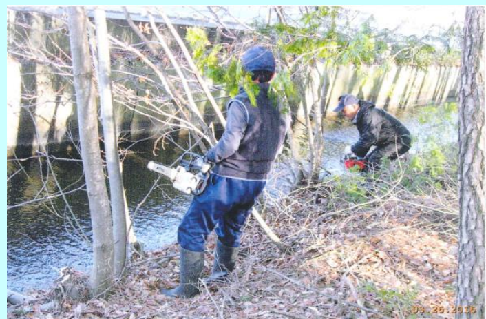
水路沿いの林地帯の刈払い
