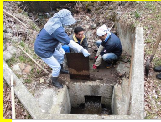
排水機能を整備(農地維持管理)
