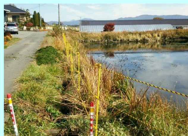
構成員の要望を叶え、ため池に安全柵を設置
