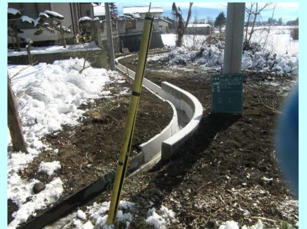
雨のたびに水が溢れた水路の更新
