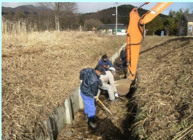
長年手の付かなかった水路の泥上げ
