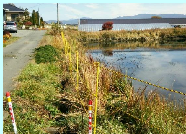
構成員の要望を叶え、ため池に安全柵を設置
