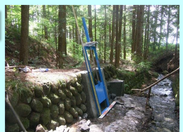
水路エゲート弁の取付け
