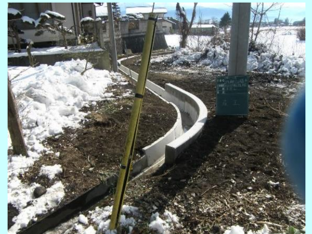
雨のたびに水が溢れた水路の更新
