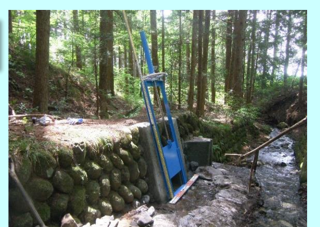
水路エゲート弁の取付け
