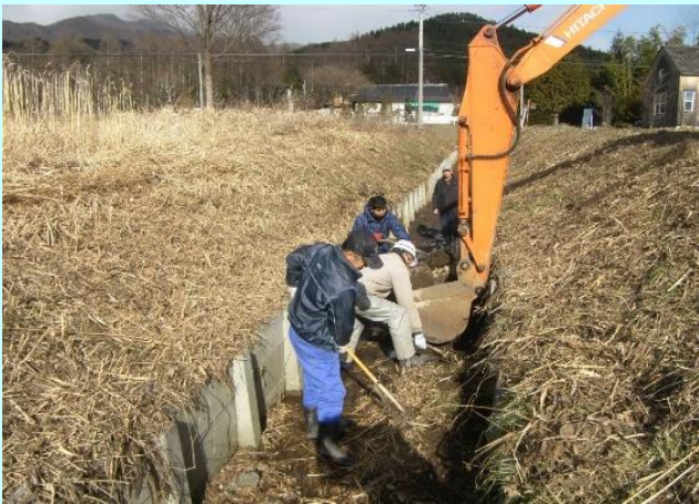
長年手の付かなかった水路の泥上げ
