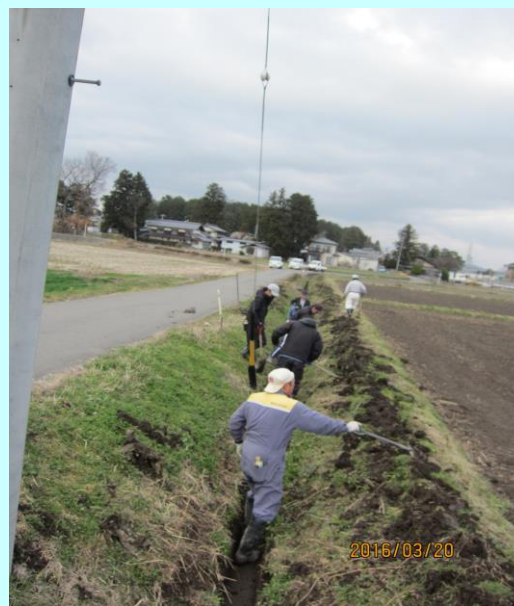
排水路の土砂上げ作業
