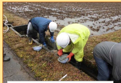
水路の目地詰め
