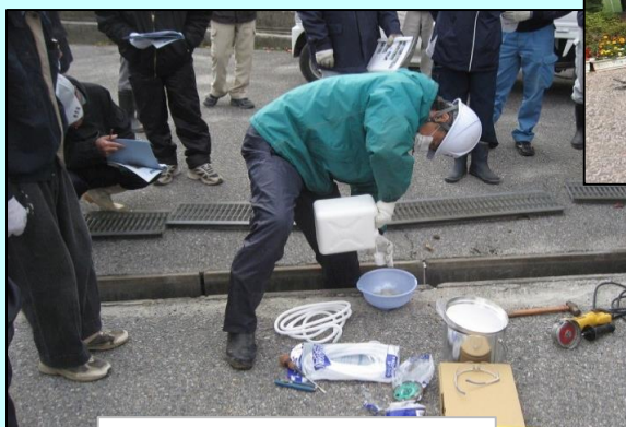
水路の目地詰め講習会
