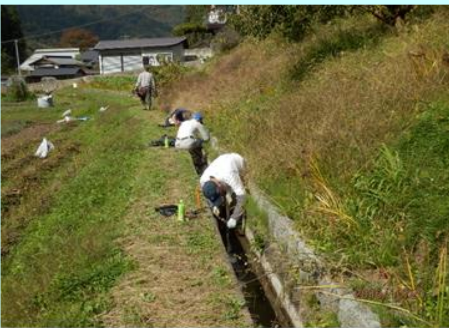
用水路の漏水を止める目地詰め作業
