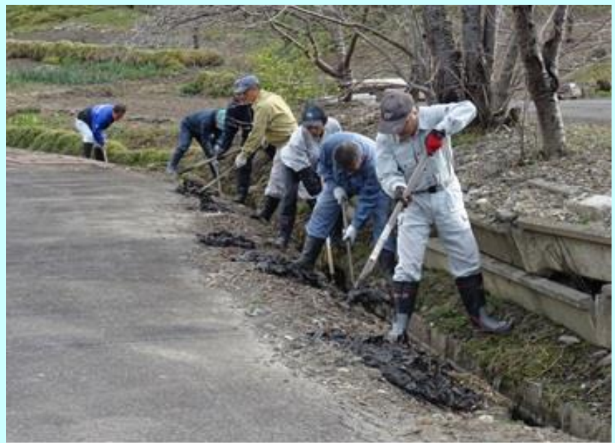
水路掃除で用排水路の維持作業
