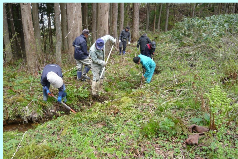
水路の泥上げ
