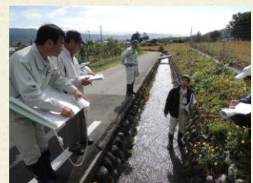
保全会、改良区、市、県、長土連による機能診断
