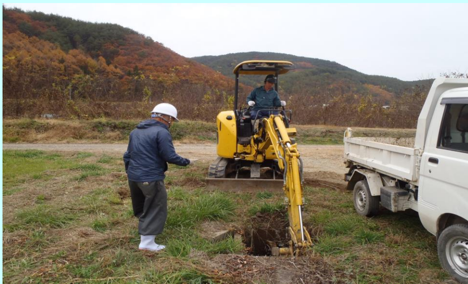
稲の刈り取り後、土砂等の堆積が見られる水路の泥上げ作業を行っています。
