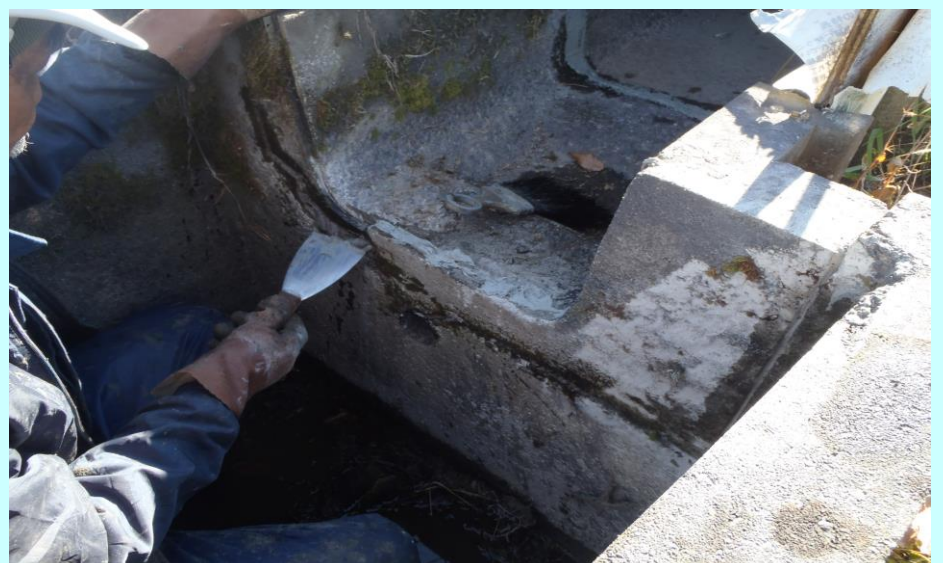
水路に水がない時期には目地補修作業を行っています。
