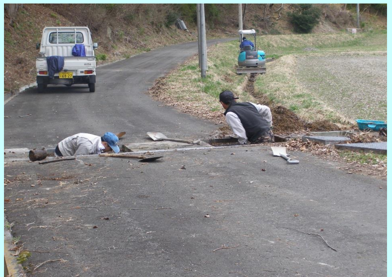
用水路泥上げ作業
