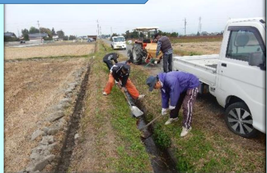
水路清掃・点検
