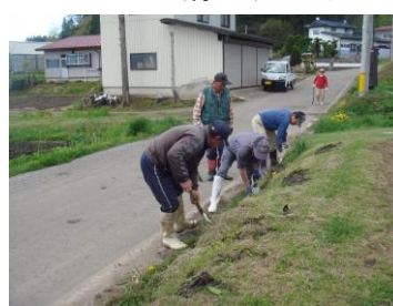
U字溝の泥上げ
