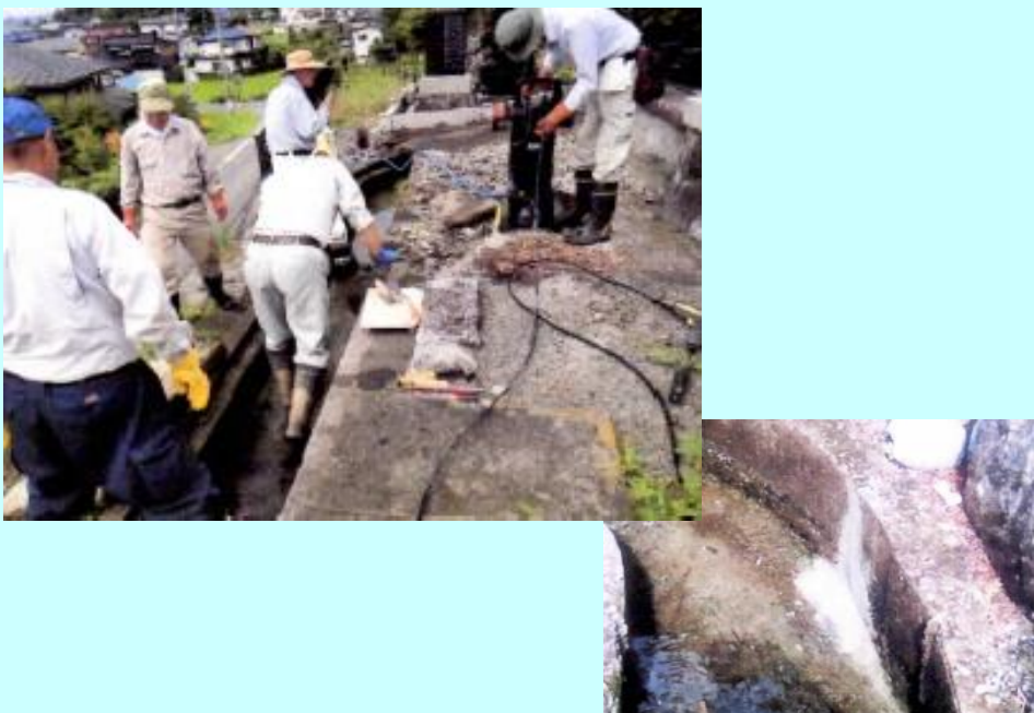
水路の破損部分補修(長寿命化)
