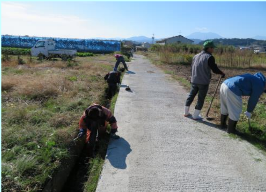
水路の泥上げ作業
