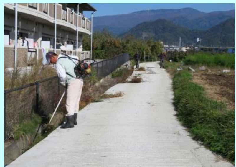
草刈り機を使って水路周囲の除草作業
