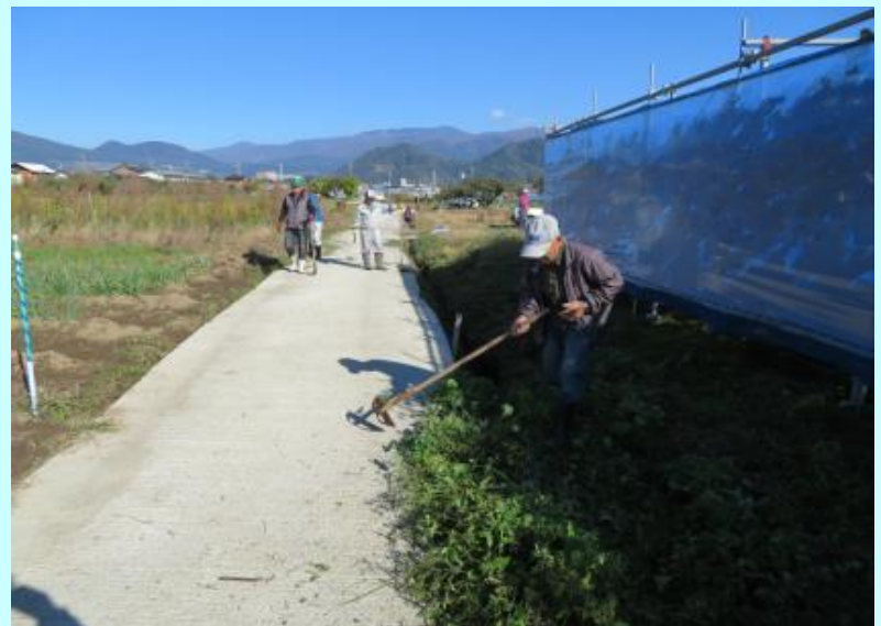
水路周辺の除草作業
