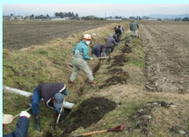
排水路の泥除去
