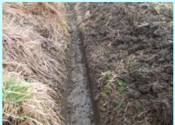
泥上げ後の状況
