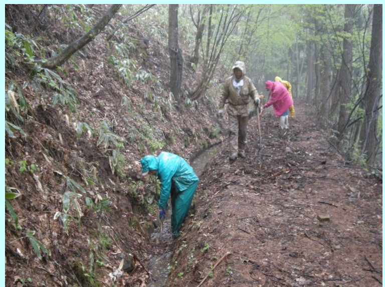
水路の泥上げ
