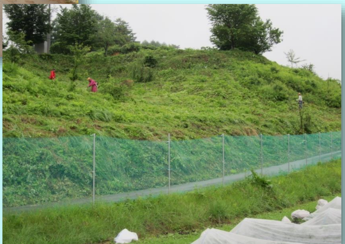
路肩・法面の草刈の様子
