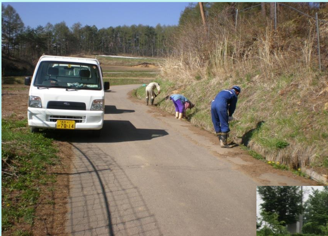
側溝の泥上げの様子
