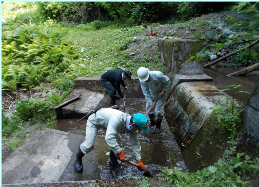
用水路の点検・整備
