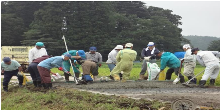
← 農道の舗装工事
