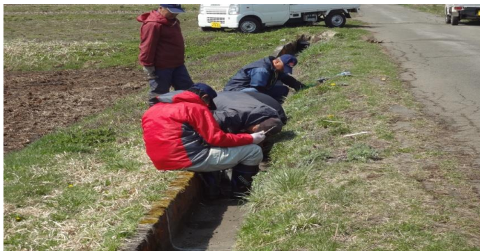
← 水路の目地補修
