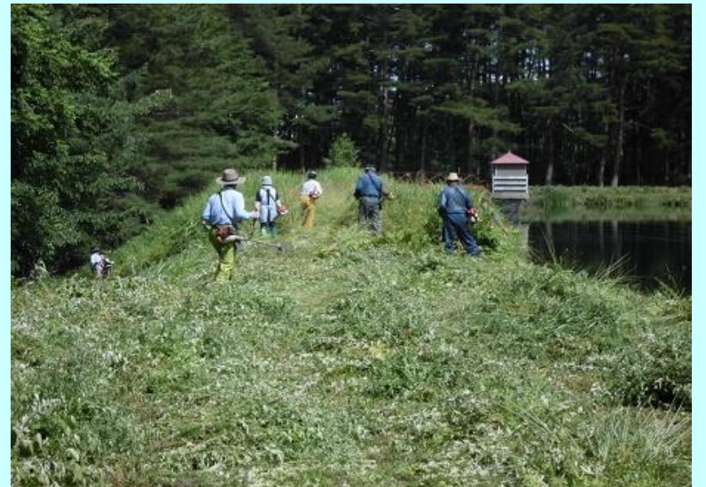
ため池堤体の草刈り
