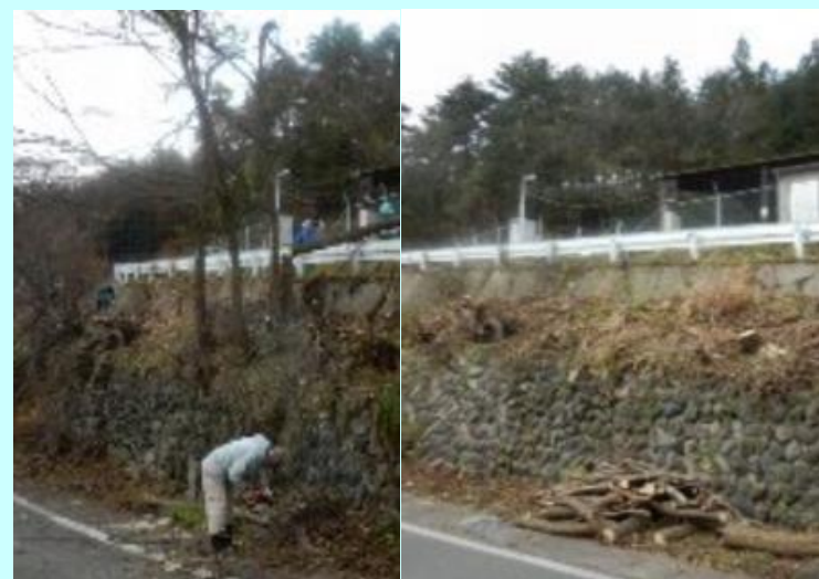
水路上部の雑木を伐採し落ち葉の堆積を防止
