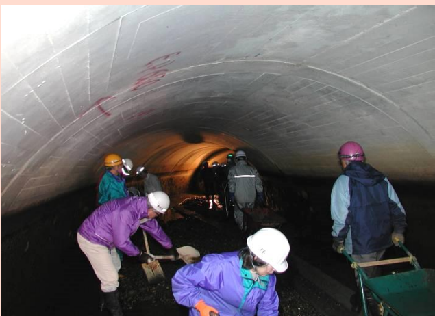
650m隧道に堆積した土砂の搬出
