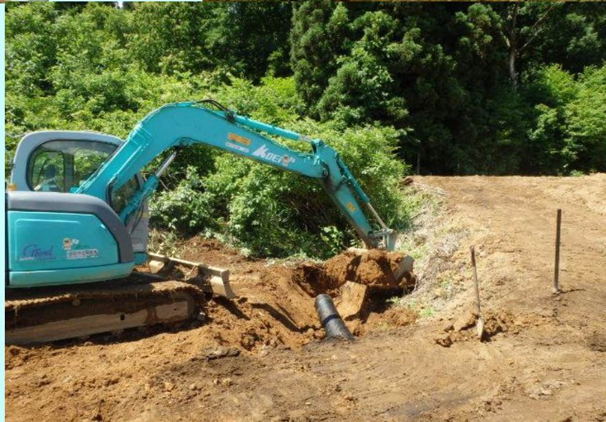
電柵設置 作業路整備 作業
