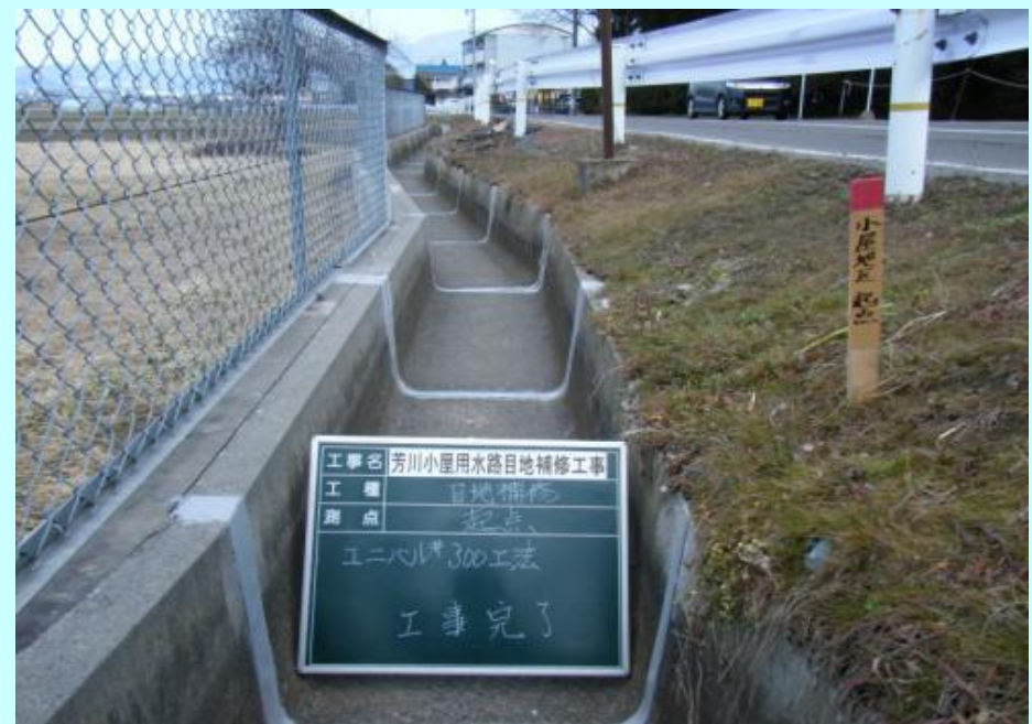
長寿命化による水路の補修
