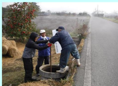
水抜き作業によるバルブの点検により1年の作業は終了します。その間に判明した修理箇所は引き続き農地維持で補修をします。
