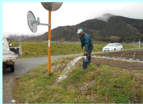
アングルバルブの点検やスプリンクラーの散水試験を行い、判明した破損個所は農地維持で補修をします。
