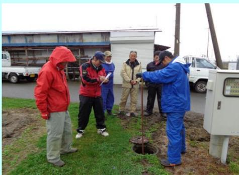
1年の始まりは、パイプラインの水張りからバルブの点検・パイプの破管等機能診断を行います。
