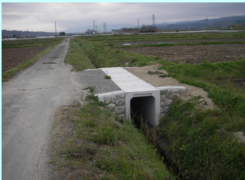
長寿命化－水路の補修
