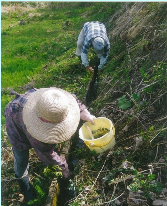
①水路補修作業(U字溝目地詰)
