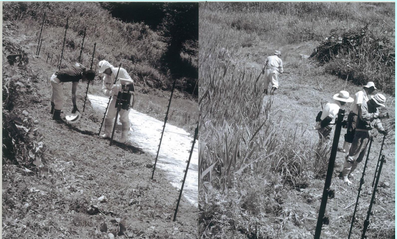
②電気柵設置作業(高さ150cm、電線5段張り)
